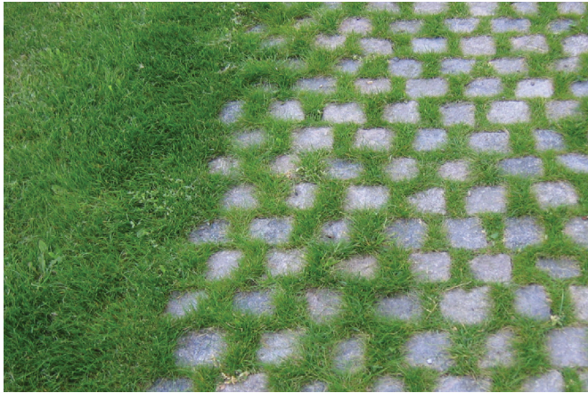
Granitbelægning med bred græsfuge
