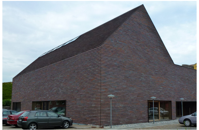
Facade og tag beklædt med skærmtegl
