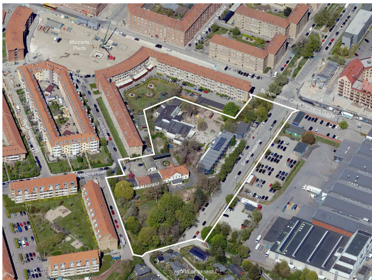
Området for Glucksvej 2 set mod nord. Lokalplanområdet er indtegnet med hvid linje, og de vigtigste gader og pladser er navngivet. Luftfoto: Klimadatastyrelsen, 2023.
