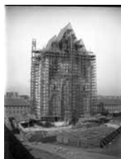
Grundtvigs Kirke kirken under opførelse.
