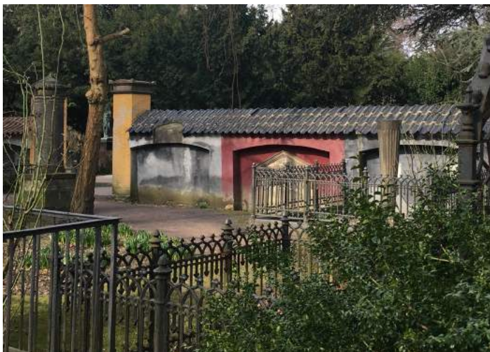
Afdeling A - Indre mur
