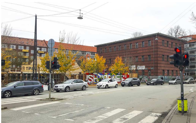
Eksisterende transformerstation og midlertidigt madmarked.
