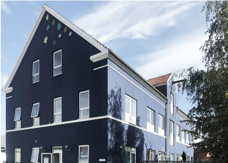
Irlandsvej 5A set mod øst fra Engelsvej/Irlandsvej.
