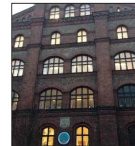
FACADER FRA FØRSKELLIGE BYGGE-PERIODER
