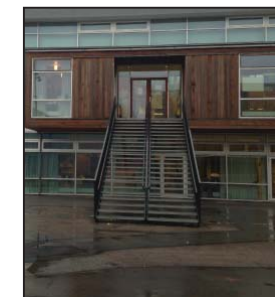
SKOLENS BYGNINGER ER I TO ETAGER OG DANNER OVERSKUELIGE RUM TIL FØRSKELLIGE FUNKTIONER
