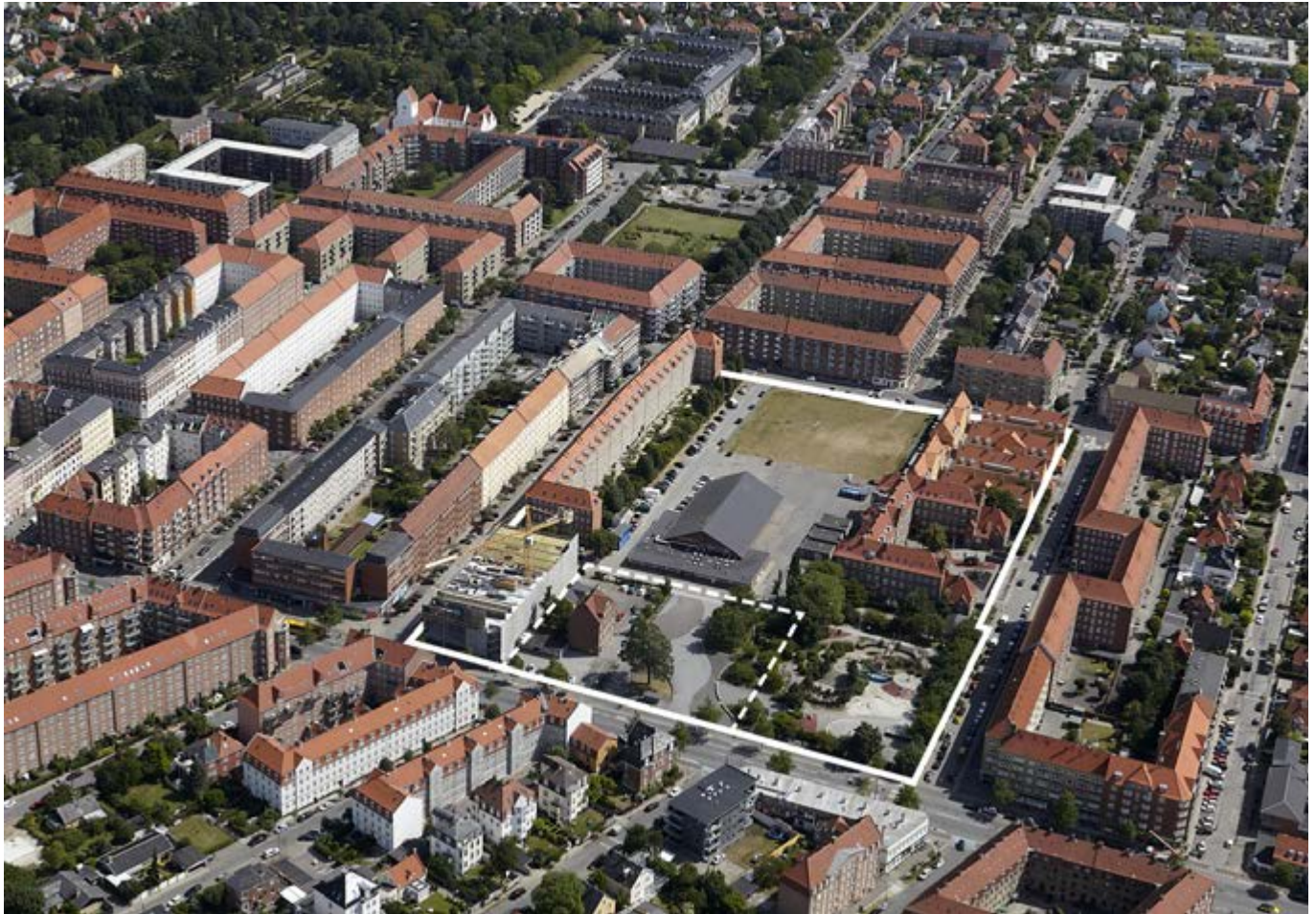
Luftfoto, juni 2014. JW Luftfoto
