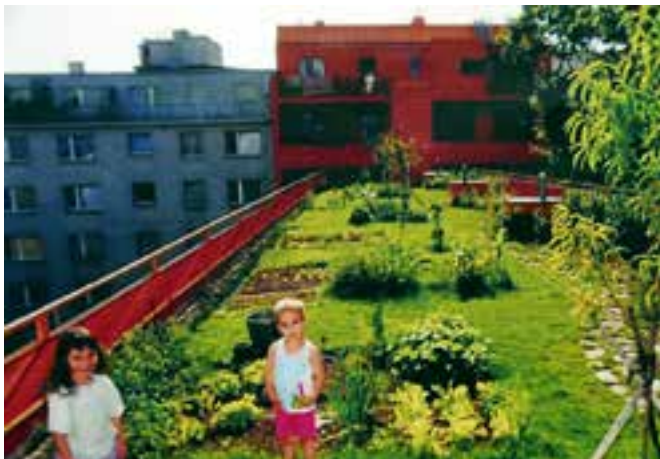
Reference 7.7. Grønt tag med regnvandsforsinkelse og opholdsmulighed.
