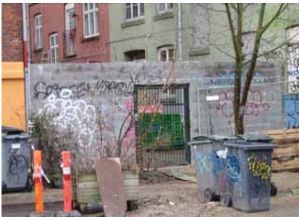
Eksisterende mur ved Dagmarsgade 45
