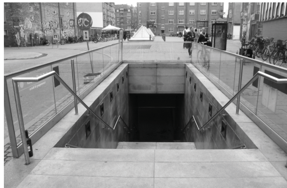
Trappenedgang til cykelkælder
