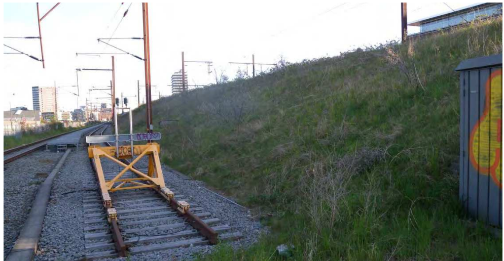
Figur 13.3 Jernbaneskråningen ud mod Kalkbrænderihavnsvej.
