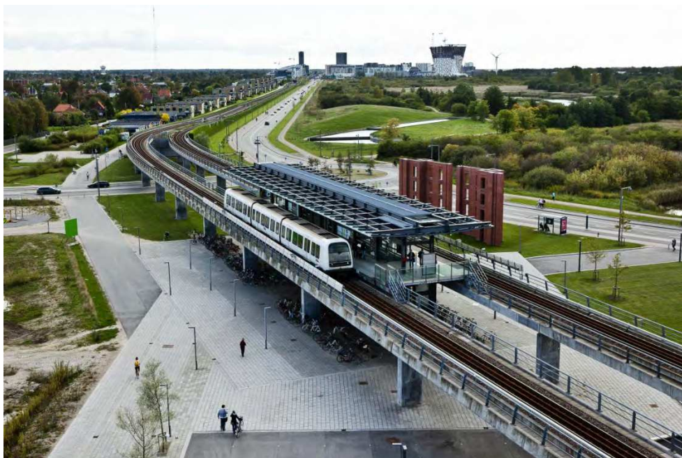
Figur 2.3 Endestationen ved Orientkaj vil blive udført som en højbanestation. Det viste eksempel er fra DR-byen station.
