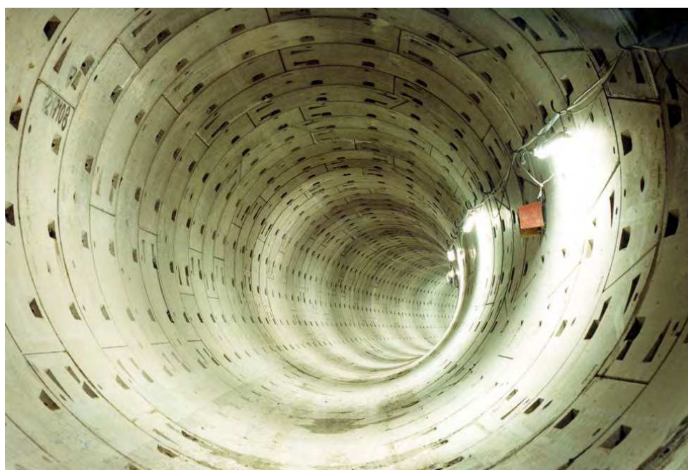
Figur 4.3 Tunnelrør beklædt med præfabrikerede betonelementer. Eksempel fra Københavns Metro.
