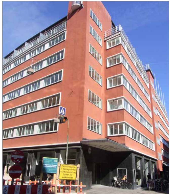
Hjørnet Nørregade/Krystalgade. Butiksarealerne i stuen står i dag tomme hen.
