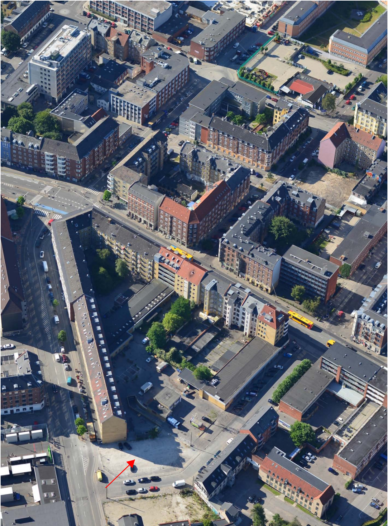
Området set mod syd. I forgrunden Blytækkervej med tom byggegrund (luftfoto fra 2012).
