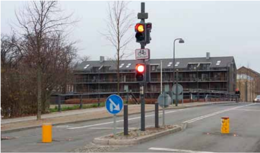
Den mekaniske bussluse syd for Frederiksholmsbroen.
