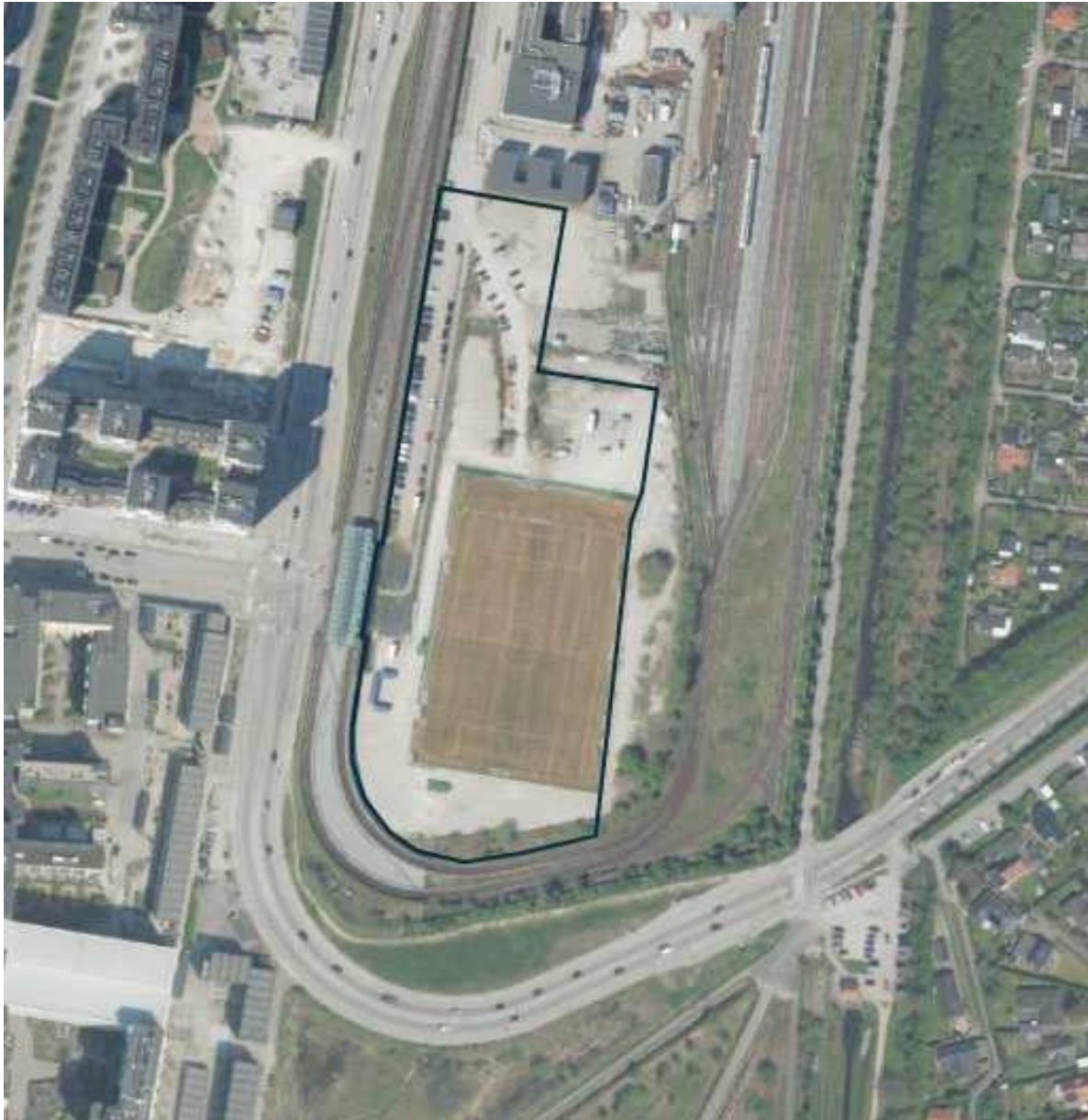
Figur 1-2 Luftfoto fra forår 2024 med lokalplanområdets afgrænsning. Mod vest ses metropassagen med cykelparkering, bilparkering langs metrobanen samt omklædningspavilloner. Mod øst ses 11-mandsbanen med "friareal" mod nord. Kilde: Danmarks Miljøportal.
