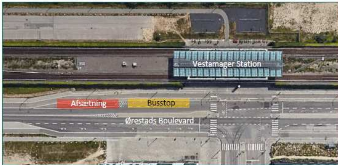
Figur 8-8 Eksisterende afsætningsforhold på Ørestads Boulevard. Foto: Google.
