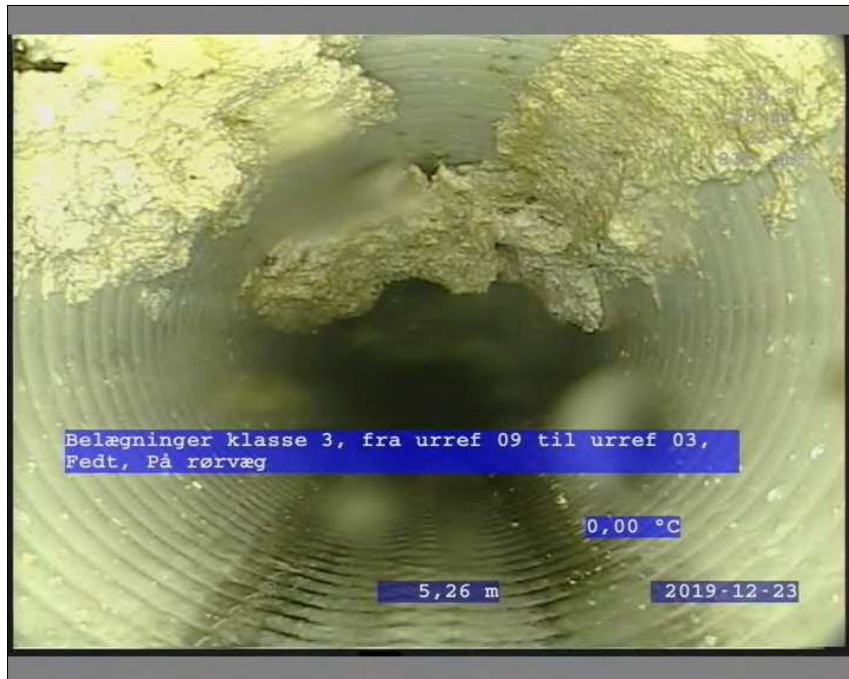
Foto: 2_5A, Medie #: TV2-414, 00:01:09 5,3m, Belægninger klasse 3, fra urref 09 til urref 03, Fedt, På rørvæg
