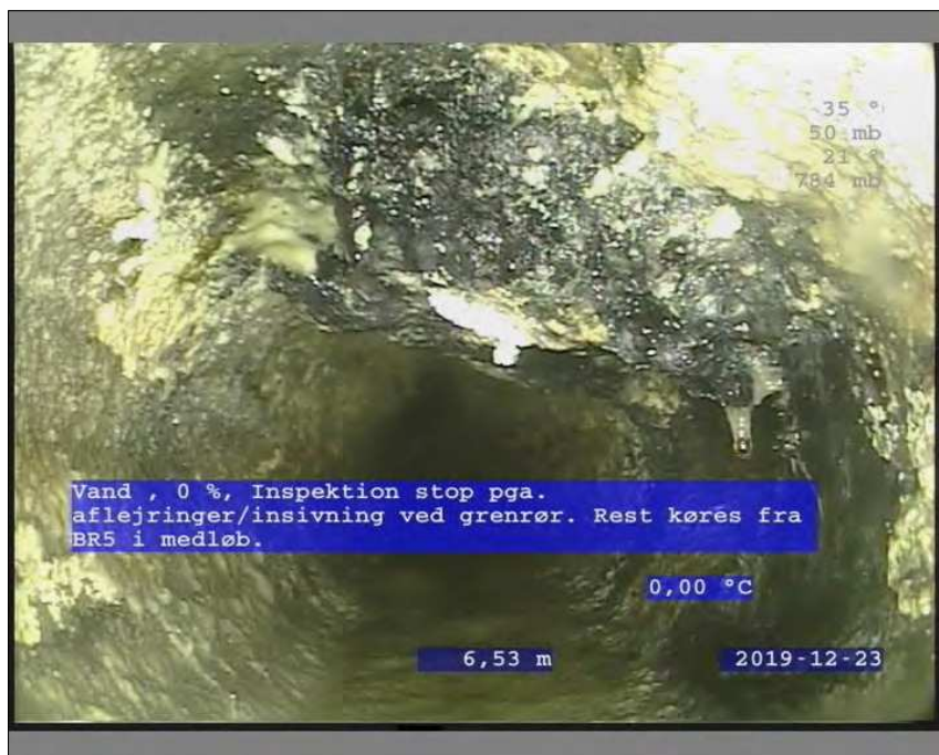
Foto: 7_11A, Medie #: TV2-414, 00:03:02 6,5m, Vand , 0 % / Inspektion stop pga. aflejringer/insivning ved grenrør. Rest køres fra BR5 i medløb.
