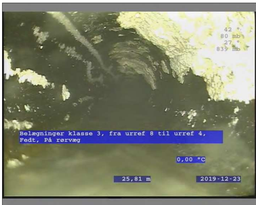
Foto: 6_21A, Medie #: TV2-414, 00:08:10 25,8m, Belægninger klasse 3, fra urref 8 til urref 4, Fedt, På rørvæg
