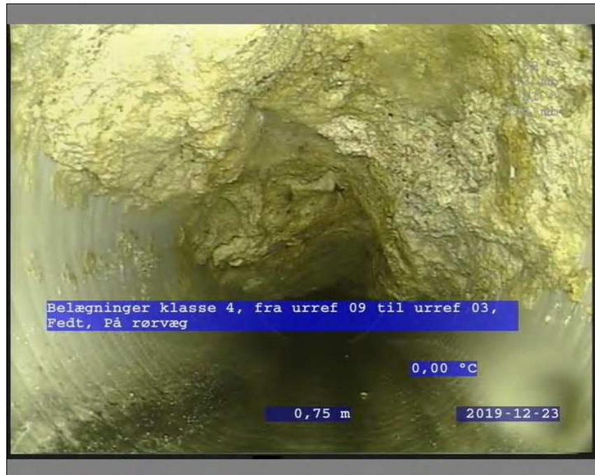
Foto: 5_2A, Medie #: TV2-414, 00:00:15 0,8m, Belægninger klasse 4, fra urref 09 til urref 03, Fedt, På rørvæg
