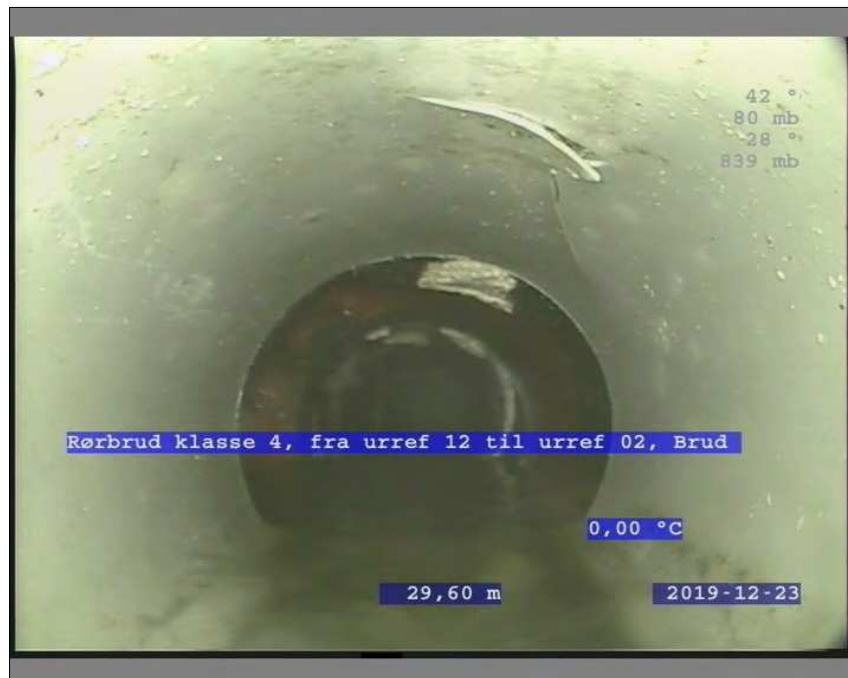
Foto: 6_25A, Medie #: TV2-414, 00:09:10 29,6m, Rørbrud klasse 4, fra urref 12 til urref 02, Brud
