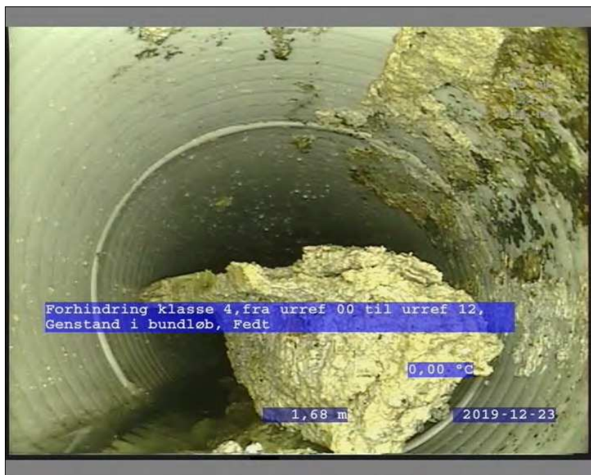
Foto: 1_4A, Medie #: TV2-414, 00:01:50 1,7m, Forhindring klasse 4, fra urref 00 til urref 12, Genstand i bundløb / Fedt
