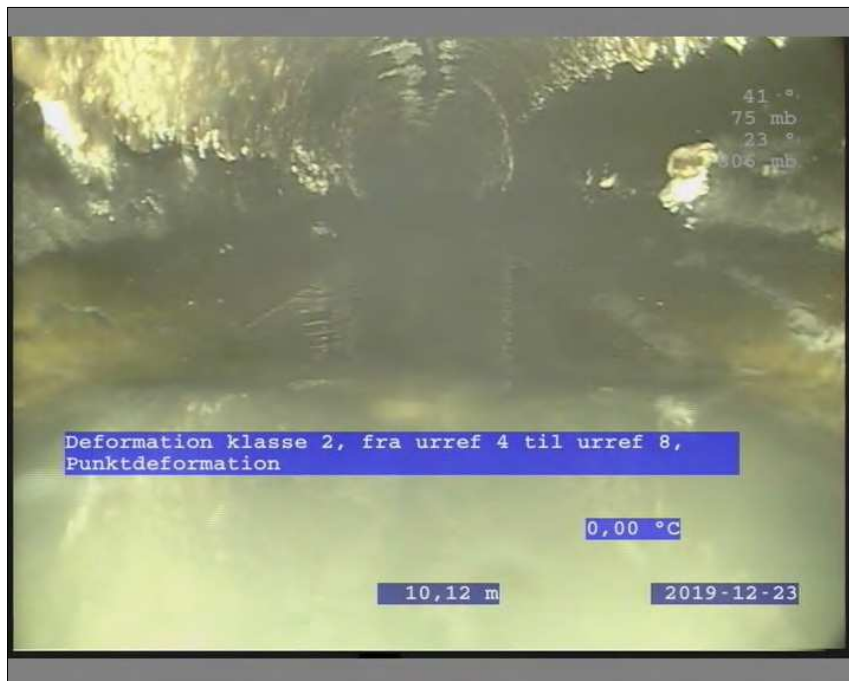
Foto: 6_7A, Medie #: TV2-414, 00:02:18 10,1m, Deformation klasse 2, fra urref 4 til urref 8, Punktdeformation
