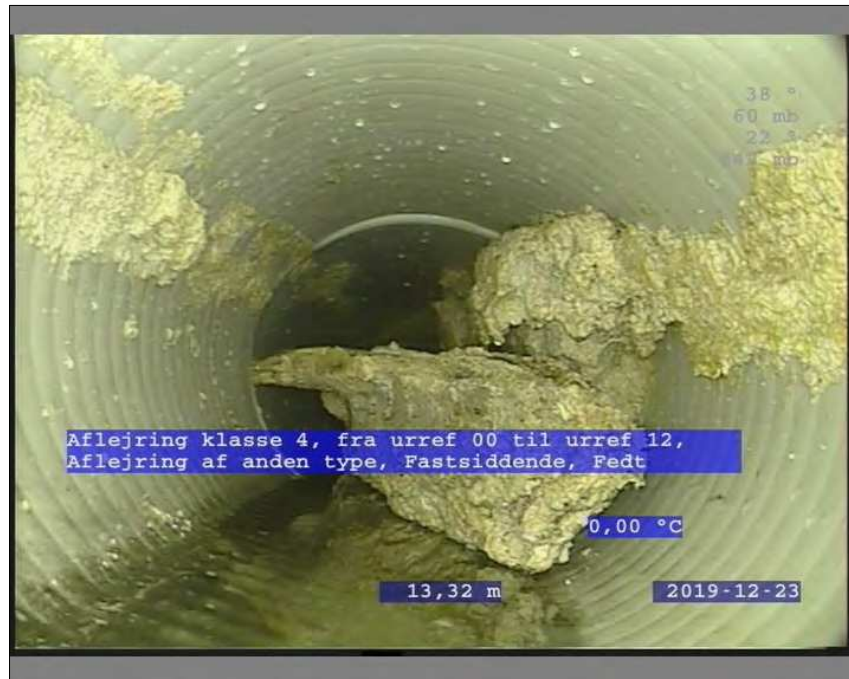
Foto: 1_5A, Medie #: TV2-414, 00:03:26 13,3m, Aflejring klasse 4, fra urref 00 til urref 12, Aflejring af anden type, Fastsiddende / Fedt
