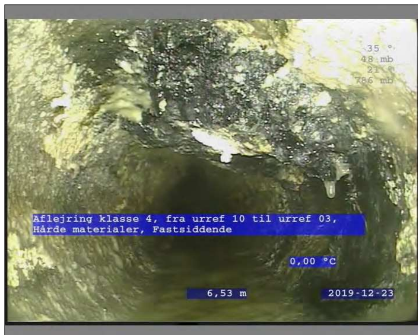
Foto: 7_8A, Medie #: TV2-414, 00:02:43 6,5m, Aflejring klasse 4, fra urref 10 til urref 03, Hårde materialer, Fastsiddende
