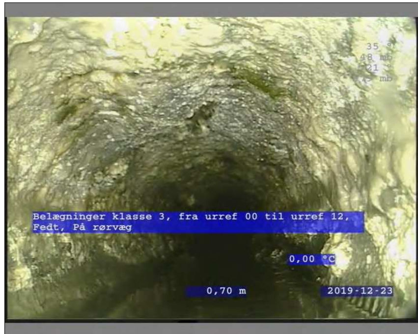
Foto: 7_2A, Medie #: TV2-414, 00:00:23 0,7m, Belægninger klasse 3, fra urref 00 til urref 12, Fedt, På rørvæg
