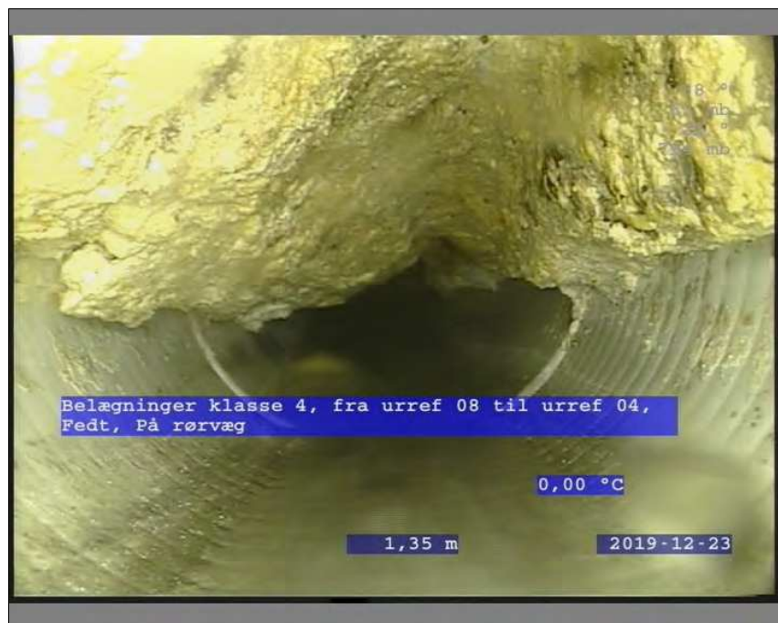
Foto: 5_3A, Medie #: TV2-414, 00:00:24 1,3m, Belægninger klasse 4, fra urref 08 til urref 04, Fedt, På rørvæg
