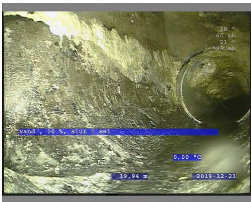
Foto: 4_17A, Medie #: TV2-414, 00:03:27 19,9m, Vand , 10 % / Slut I BR1
