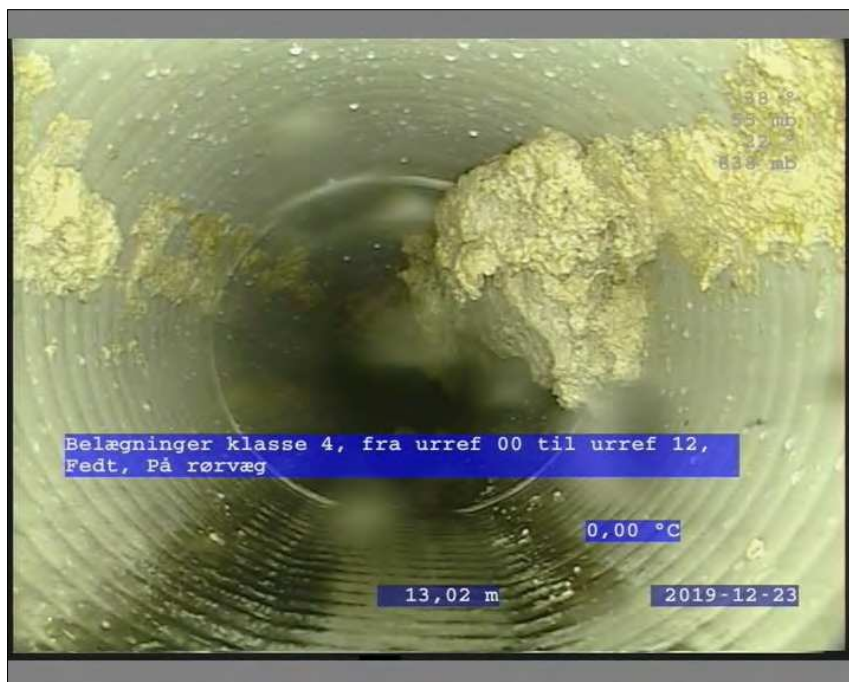
Foto: 2_10A, Medie #: TV2-414, 00:01:58 13m, Belægninger klasse 4, fra urref 00 til urref 12, Fedt, På rørvæg
