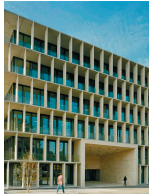
BRISE SOLEIL: Tydeligegøre grid ved facadekomplettering. Her i Zürich.
