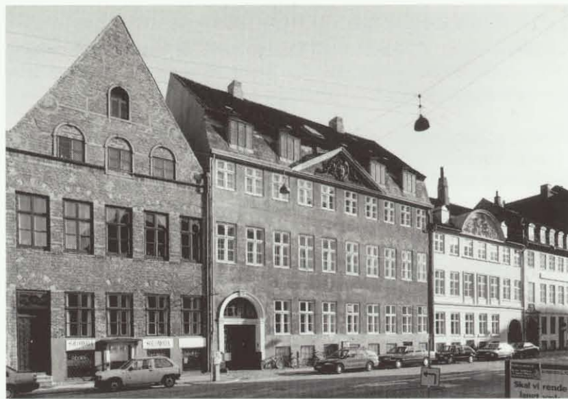
Strandgade 28-22 fra venstre mod højre. Nr. 26 og 28 blev opført i 1626 som tre ens gavlhuse, i 1769 blev de to (nuv. nr. 26) ombygget til en samlet bygning.
