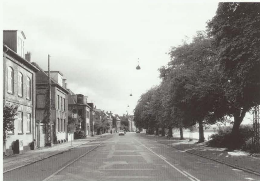
Øster Søgade set mod sydvest. Den lave bebyggelse skaber en stilfærdig byfront mod Sortedams Sø. Gadens forløb understreges af en smuk træerække.
