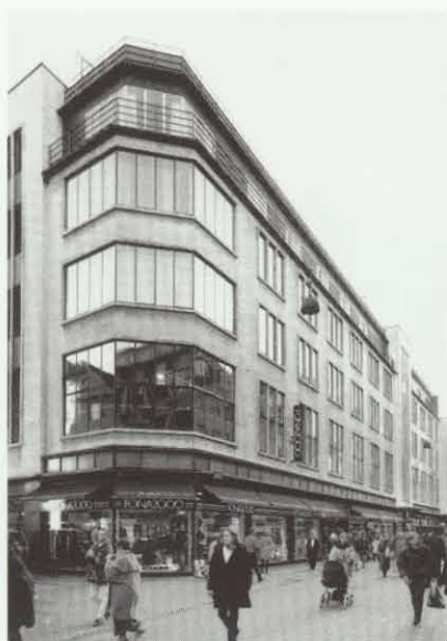
På Østergade 47-51 blev der i 1938 opført et stormagasin for A. Fønnesbech A/S med O. Gundlach-Petersen som arkitekt. Den 6 etages bygning er opført i jernbeton med tilbagetrukket tagetage. Facaden er beklædt med natursten og indgangspartiet er let fremhævet med et gennemgående vinduesmotiv.
