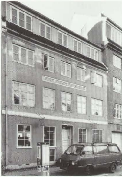
Badstuestræde 17 blev opført i 1832. Den fireetages bygning har en kraftig vandret opdeling af facaden. Den nederste del - høj kælder og stueetage - fremstår pudset, den øverste del er i gule sten. To vandrette bånd markerer overgangen. Den stilfærdige facade domineres af en stor flot rødmalet port med vindue over, begge med fine detaljer.
