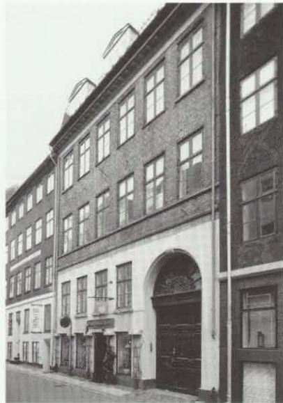
Teglårdstræde 9 blev opført først i 1800-tallet og har senere fået en fabrikketage. Et symmetrisk femfags hus med pudset facade og tegl på taget. Facaden prydes med kordongesims og la grecque bort.
