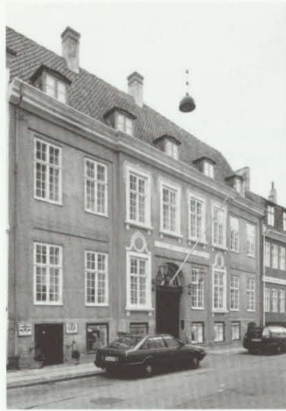
Brigadér Hallings Gård, Lille Strandstræde 14 blev opført i 1600-tallet og ombygget i 1773-76, formodentlig af Hans Næss. Den pudsede facade er tredelt med en trefags midrisalit. Porten er anbragt forskudt for midteraksen på grund af dens placering i det oprindelige hus. Risalitten er dekoreret med medaljoner og guirlander, og vinduerne er indrammet. Et lille bypalæ med Louis Seize-inspiration, som Hans Næss må antages at have set hos sin lærer Jardin, der indførte stilen i Danmark.
