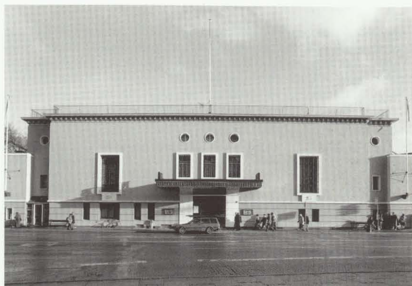
Restaurant Nimb, Bernstorffsgade (herover), blev opført i 1909 i tivistil af arkitekt Knud Arne-Petersen og senere i 1927 ombygget af arkitekt Anton Rosen. Huset er symmetrisk opbygget omkring indgangspartiet, facaden er pudset og forsynet med fuger i et geometrisk mønster. De få vinduer er markeret med en enkel indfatning og gitterværk. I anledning af en overenskomst indgået mellem Københavns Magistrat og Tivoli i forbindelse med lejefornyelse blev Anton Rosen bedt om at tegne et forslag til omformning af Tivolis facade mod Bernstorffsgade. Herunder er vist et udsnit af Rosens forslag til Tivolis facade mod Bernstorffsgade.
