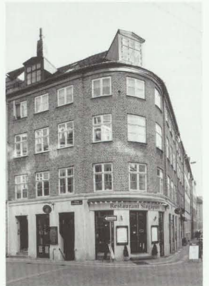
Hjørneejendommen Knabrostræde 19 (til højre) har et trefags rundet hjørne, idet det efter branden i 1795 blev påbudt, at alle hjørner skulle "brækkes". Den fireetagers ejendom fremstår i dag i røde sten med pudset underetage, og et enkelt bånd markerer overgangen.
