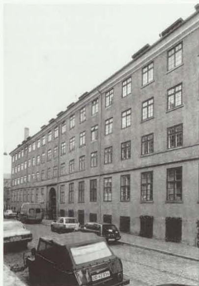
Wildersgades kaserner blev opført i 1802 af arkitekterne J.H. Rawert og Andreas Hallander. En smuk, stram klassicistisk bygning i fire etager symmetrisk opbygget omkring porten. Opført i tegl og med tegl på taget.
