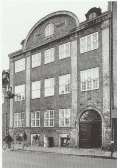
Nørregade 13 blev opført i 1734 efter Københavns brand 1728 efter J.C. Kriegers typetegninger. Huset er opført i tre etager med segmentfronon. Facaden, der er i røde sten, deles af pilastre med kapitæler i to smalle sidepartier og et bredere midtparti. Et fint barokhus med palæinspireret facade.
