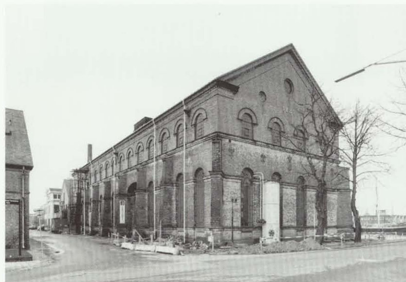
Kedelsmedien, Frederiksholm 46, er tegnet af arkitekt C.T. Andersen og bygget i 1886-87. Den store velproportionerede hal er i opført i blank mur i rundbuestil med jernvinduer og skifer på taget. Facaden, der er rytmisk opbygget med stræbepiller, prydes af bånd, indfatninger og fint markerede stik. En gedigen velbevaret industribygning.
