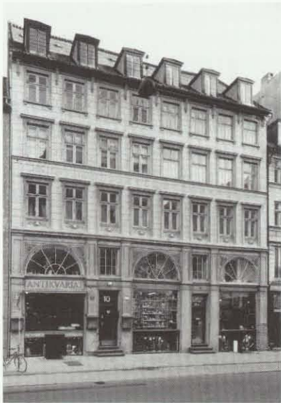
Bredgade 10 blev opført i 1852-53 efter arkitekt Moyels tegninger. Den ottefags facade er kvaderpudset og med markante vinduesindramninger. Vandrette bånd markerer facadens opdeling. I stueetagen er bevaret nogle af byens ældste rundbuede butiksvinduer med støbejernsrammer.
