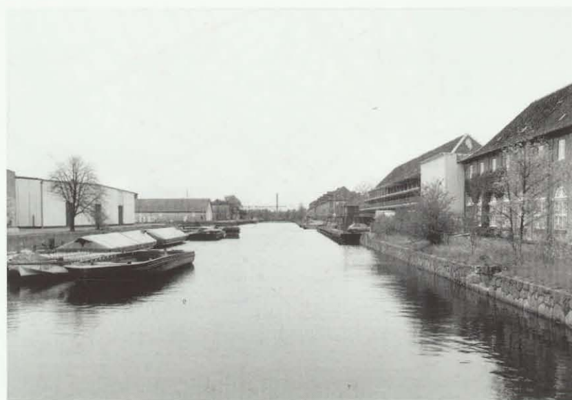
Holmens bygninger er placeret langs et regelret vejnet. Set mod nordøst over Takkeloftgraven.
