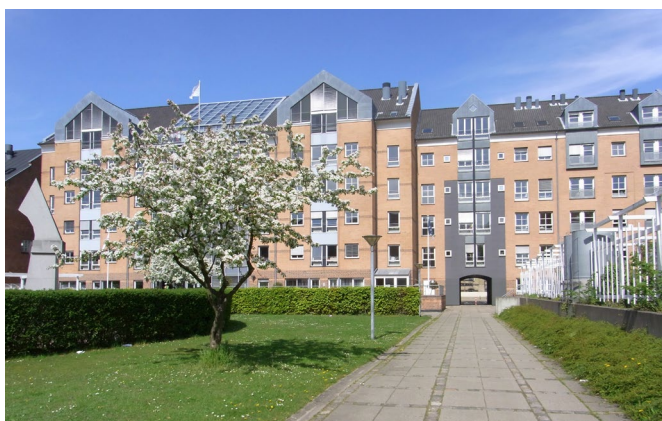
Stiforbindelsen gennem karréen med det grønne gårdrum til venstre og det hævede plateau til højre
