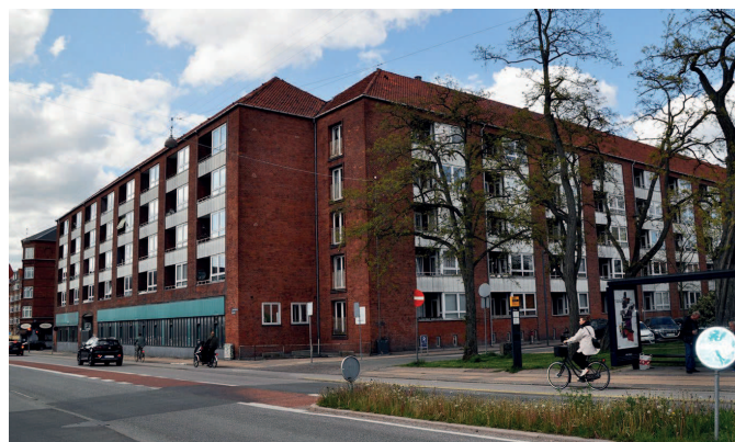
Eksisterende bebyggelse, hjørnet v. Sundholmsvej
