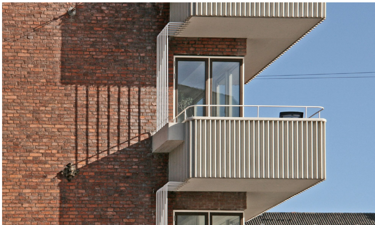
Torvegade. Smukt restaureret oprindelig altan, der harmonerer med vinduet.
