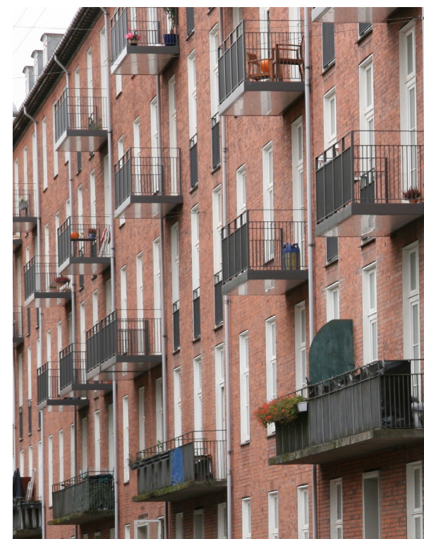
Ejderstedgade. Altaner der er frit placeret indenfor et fast mønster. Den enkle udformning og den nogenlunde jævne fordeling gør, at facaden opleves varieret.
