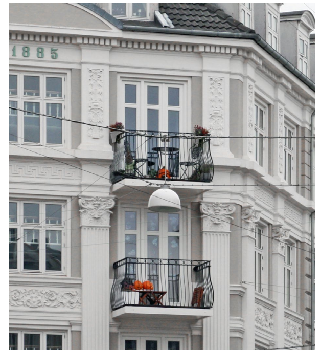
Istedgade. Altanerne fjerner dekorationen mellem søjlerne, men respekterer de lodrette søjler. Sammen med den enkle hvide bund og de fint tilpassede spinkle værn skabes en god helhedsvirkning.
