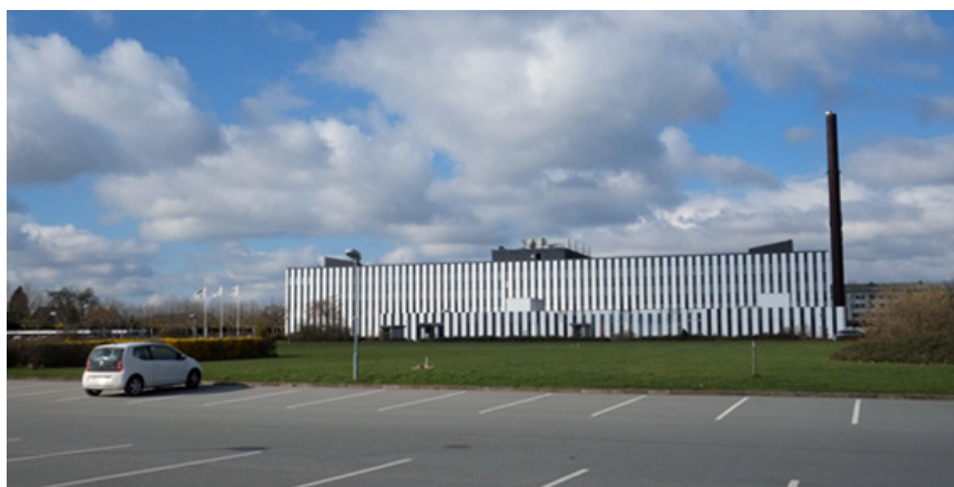
DXC set fra parkeringsarealet ved Retortvej. Foto: Arkitema.
