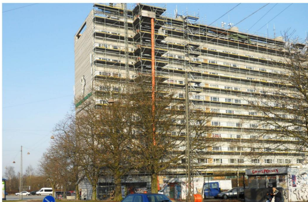
Kollektivhuset under renovering
