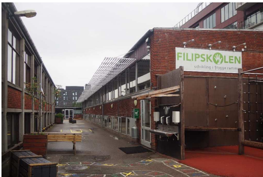
Amager Strandvej 124 bygning 1 og 3 set fra øst.
