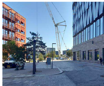
Byrumsforløbet set mod krydset, hvor materialer og farver på nybyggeri er repræsenteret.
