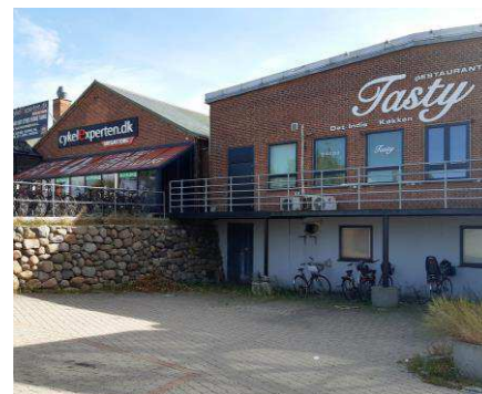
Eksisterende byggeri på matrikel 3450 der foreslås nedrevet - oprindeligt elastikfabrikken Arwill
