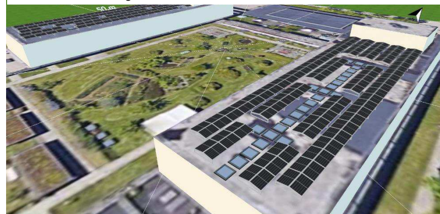
Figur 10 Modulflader med solceller. Kilde: PV*SOL-simulering
