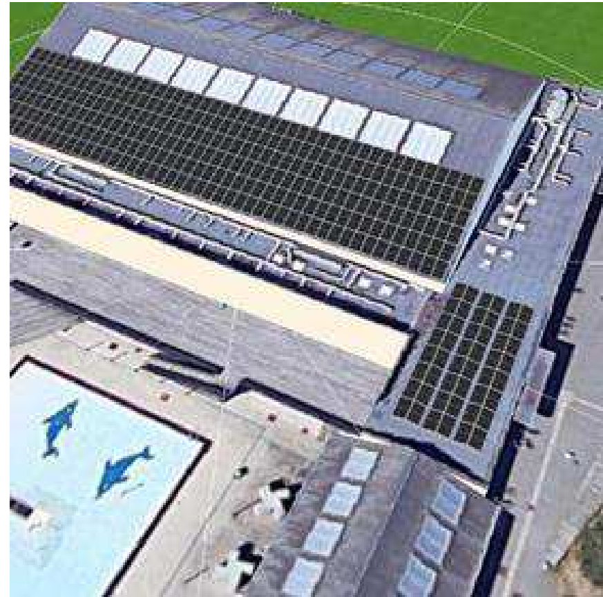
Figur 2 Modulflader med solceller. Kilde: PV*SOL-simulering
