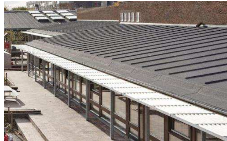
Figur 3: Billede af tagbelægning.
