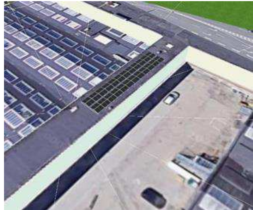
Figur 2 Modulflader med solceller.
