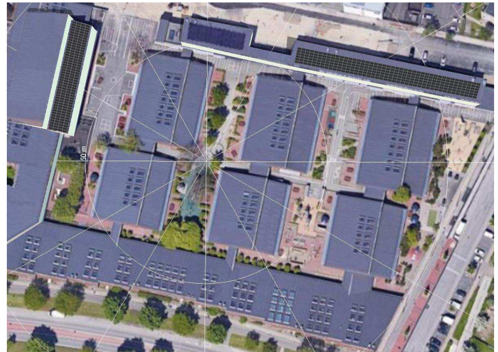
Figur 2 Modulflader med solceller. Kilde: PV*SOL-simulering
