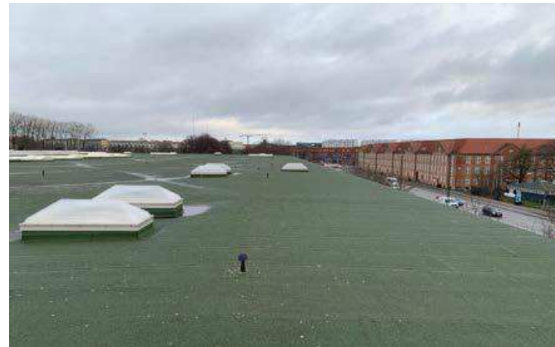
Figur 3: Billede af tagbelægning. Kilde: Tilstandsvurdering 2022
