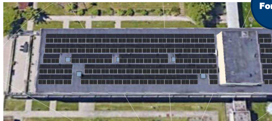
Figur 9 Modulflader med solceller. Kilde: PV*SOL-simulering
