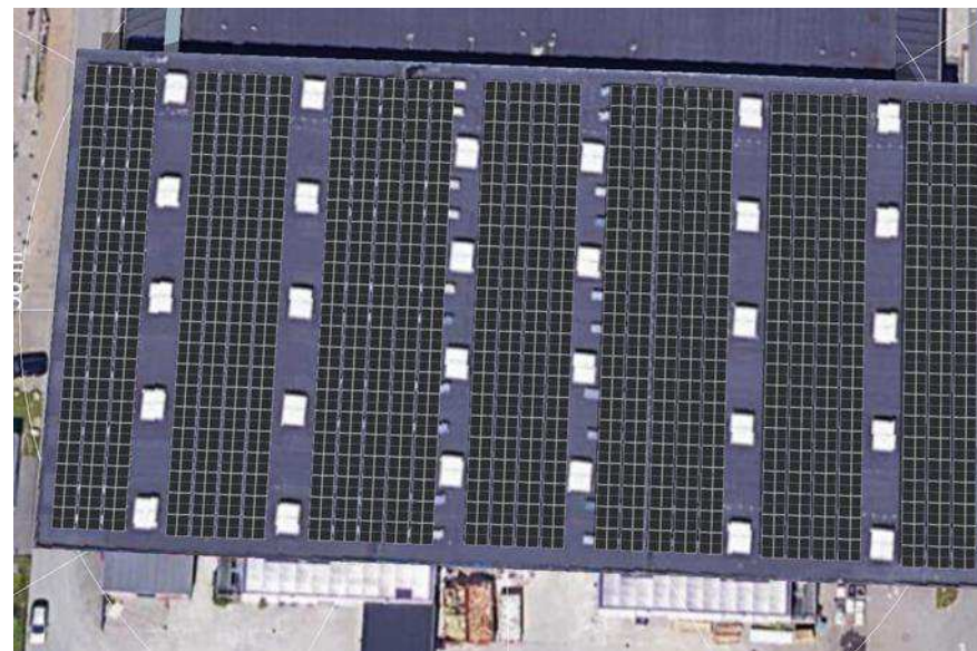
Figur 2 Modulflader med solceller.
