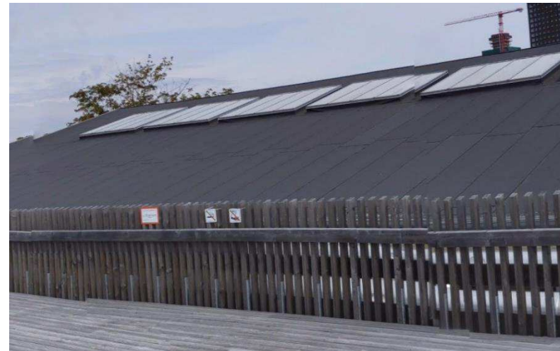
Figur 3: Billede af tagbelægning. Kilde: GoogleMaps juli 2020
