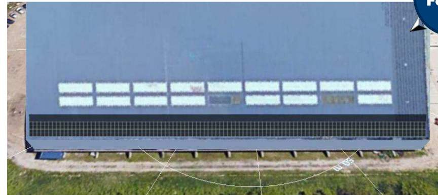
Figur 9 Modulflader med solceller. Kilde: PV*SOL-simulering
