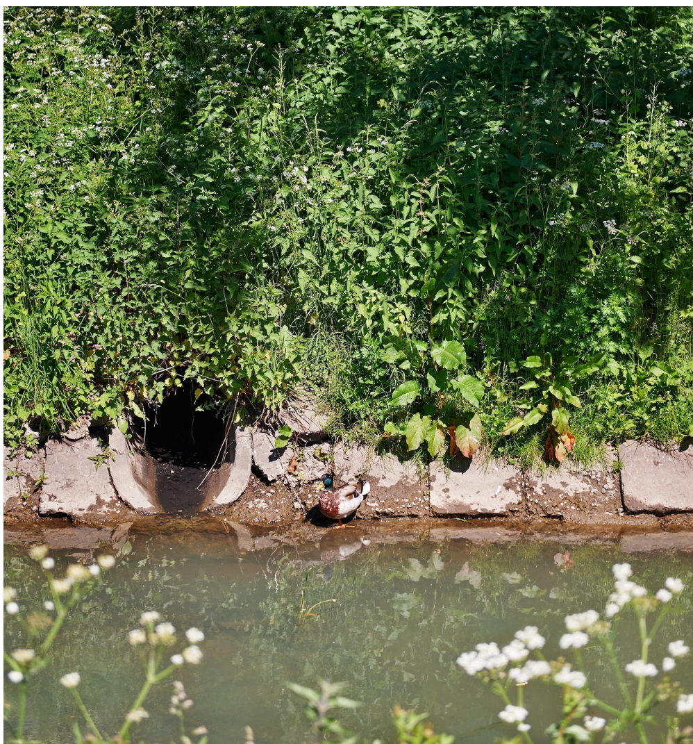
Regnvandsudløb ved Harrestup Å. Foto: HOFOR
