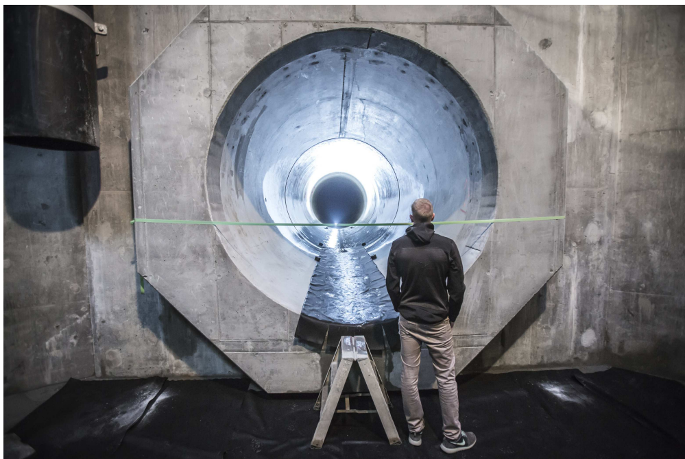
Østerbro skybrudstunnel. Foto: HOFOR
