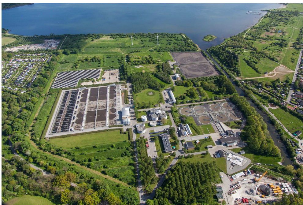
Renseanlæg Damshusåen. Foto: Hviid Photography
