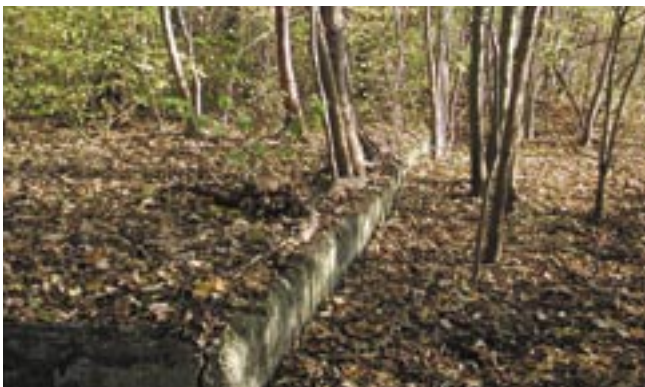
Fundament af en af de tidligere kaserne bygninger overgroet med skov.
