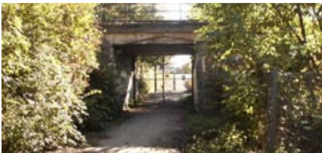
Den lukkede tunnel under jernbanen til Svanemøllen Kaserne.
