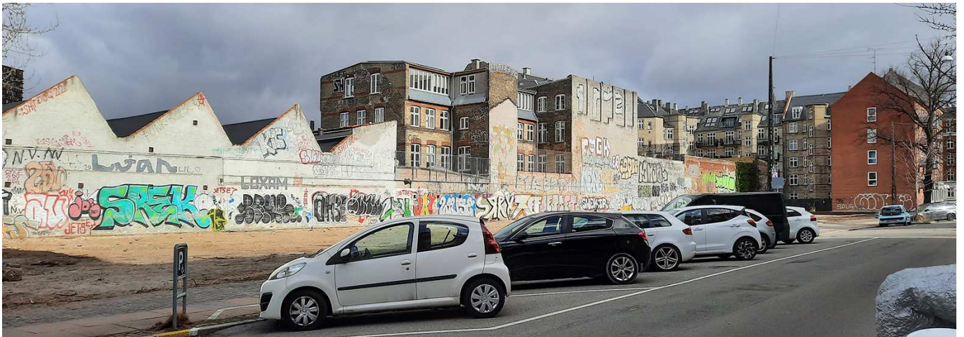
Baldersgade 5-7 set fra syd mod nord. Til venstre ses shedtag og gavl af den gamle bolt- og møtrikfabrik i Bragesgade.
