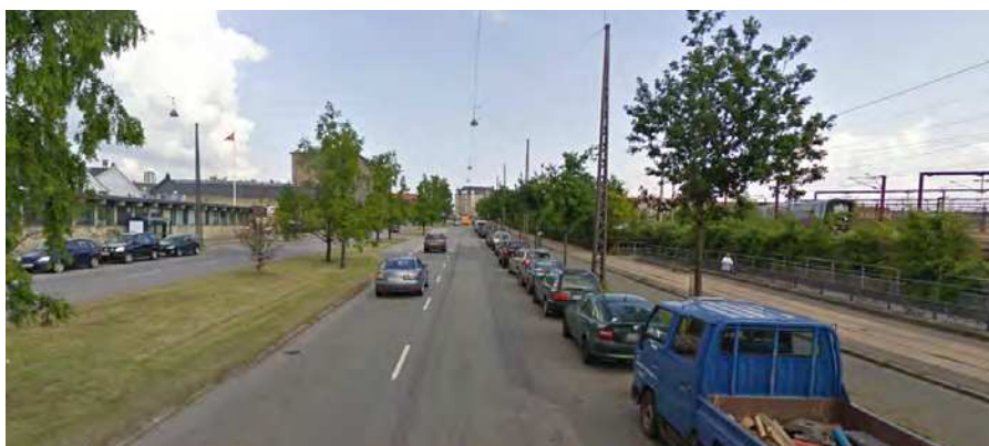
Enghavevej. Til højre bag fortovet ses rampen til stitunnelen.
