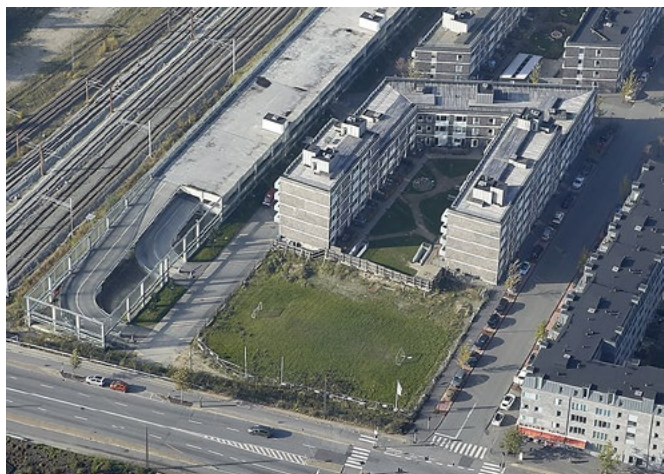
Den tomme grund omgrænset af Ib Schönbergs Allé, Gammel Køge Landevej og Poul Reichardts Vej, hvor der planlægges ungdomsboliger. Parkeringsanlægget til venstre i billedet fungerer som støjskærm. (JW Luftfoto oktober 2014)
