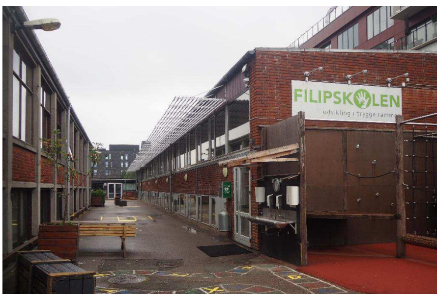
Amager Strandvej 124 bygning 1 og 3 set fra øst.
