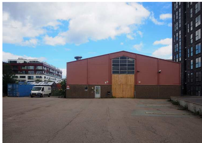
Delområde B, Krimsvej 17B. Den røde erhvervsbygning på ejendommen kan nedrives og erstattes af nybyggeri.
