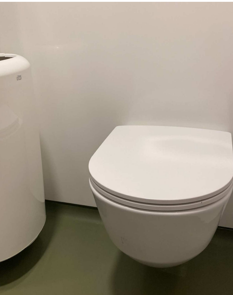
Et væghængt toilet minimerer rengøringsflader og rengøring af gulvet lettes.
