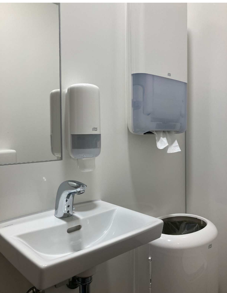
Spejl er smallere end håndvaskens bredde. På den måde sikres korrekt placering af sæbedispenser.
