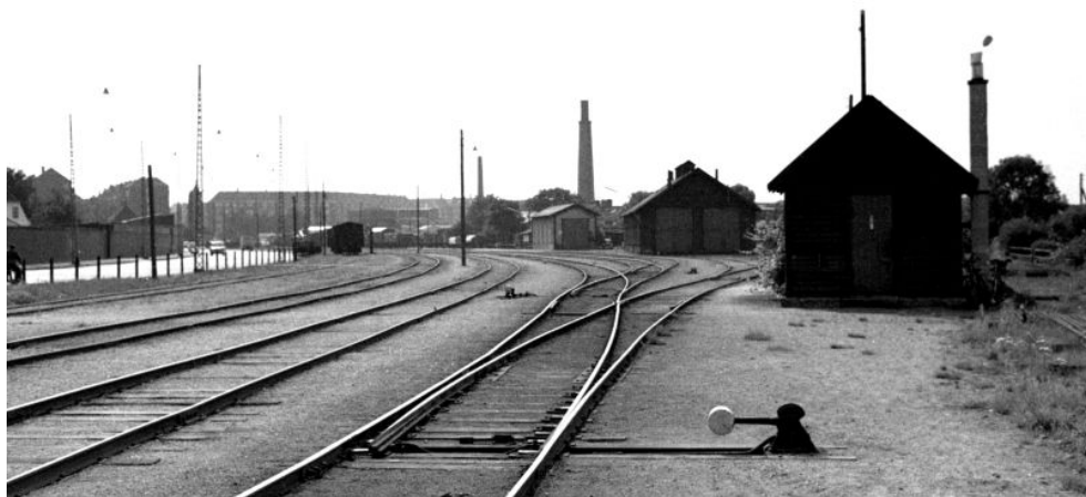
Referencefoto af arealet, som det så ud i 1963 med de to remisebygninger bagerst. Bemærk det jævne grusterræn, som næsten dækker svellerne. Til højre fornemmes, at sidesporet til rensestationen allerede er ved at gro til. Foto; Erik V. Pedersen
