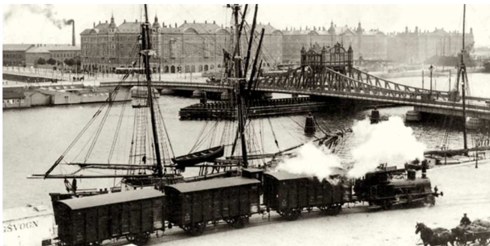
Et godstog på Havnesporene mod den nye godsbanegård på Christians Brygge, 1904. Den nye Langebro i baggrunden gav for første gang tog mulighed for at krydse havnen til Amager. Foto: Det kongelige Bibliotek.
