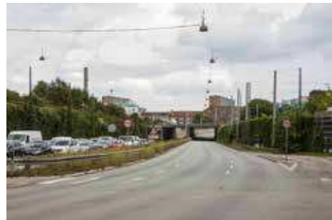
A Tunnel under S-banen set fra Nordvest
