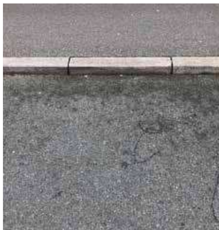
FAST BELÆGNING UDEN FUGE MEN INKL. FUGE MOD KANTSTEN
