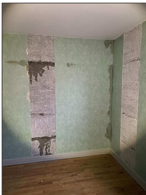
Figur 4.1. Støbeskel i vægge på SAB1.
