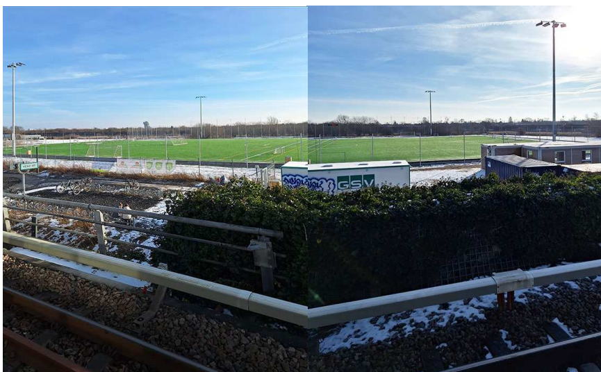
Den eksisterende kunstgræsbane set fra Vestamager Metrostation.
