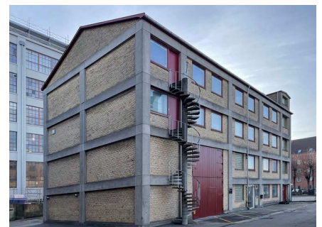
8. Kortslutnings-prøvestation fra 1959, der udpeges som bevaringsværdig.
