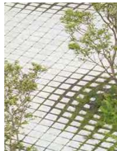
Permeable overflader som del af belægning
