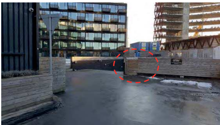
Figur 2 dårlig oversigt over rampeforløbet og evt. modkørende
