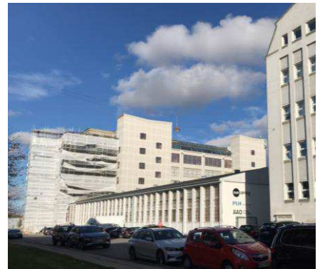
Tidligere fabriksbygninger for Lauritz Knudsens Fabrikker set fra Vermundsgade mod nord.
