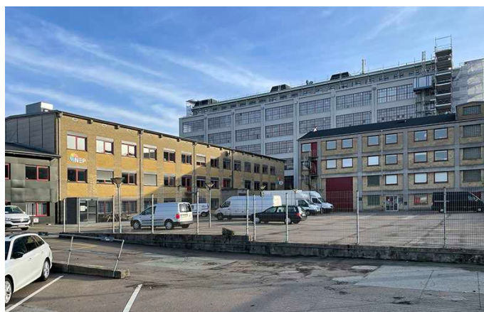
Billedet ses mod syd mod Vermundsgade 40C og i baggrunden 40A-B.
