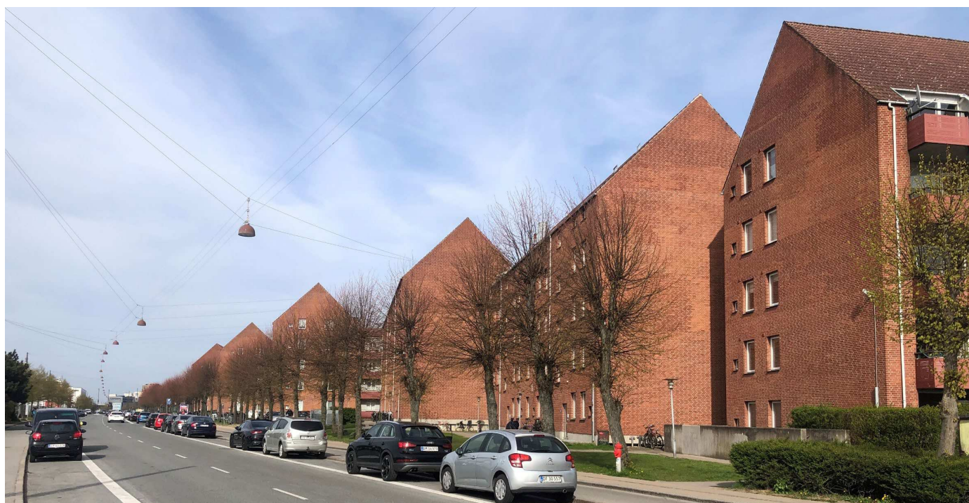
Billedet ses mod nordøst ad Rovsingsgade. Forskudte gavle i røde mursten er karakteristisk for gaderummet ved Rovsingsgade. Foto: Tegnestuen Vandkunsten.
