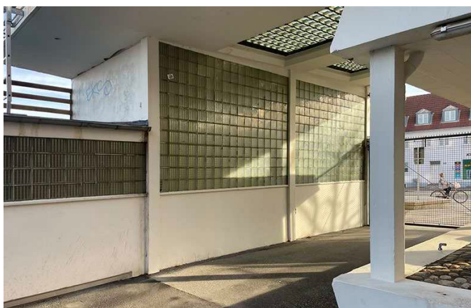
Portbygning i puds og glasbyggesten set mod Haraldsgade.
