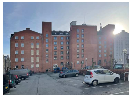
4. Fabriksbygninger opført mellem 1921-1942, der udpeges som bevaringsværdig.
