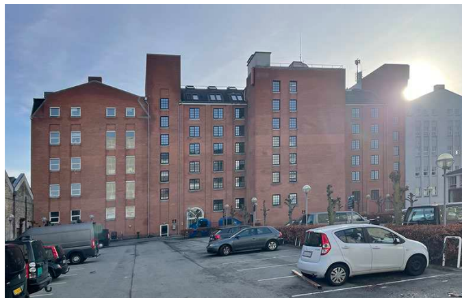
Billedet ses mod syd fra gårdrum mod Vermundsgade 38C, E, H og F.
