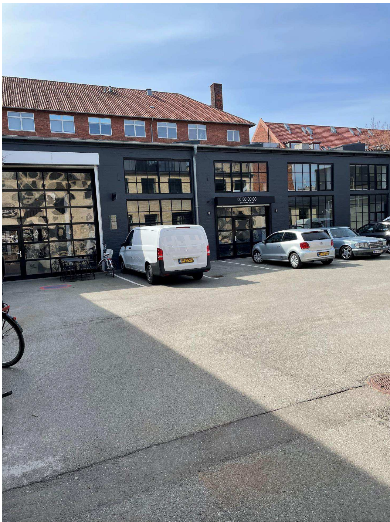
Baghuse til Glentevej 45-51
