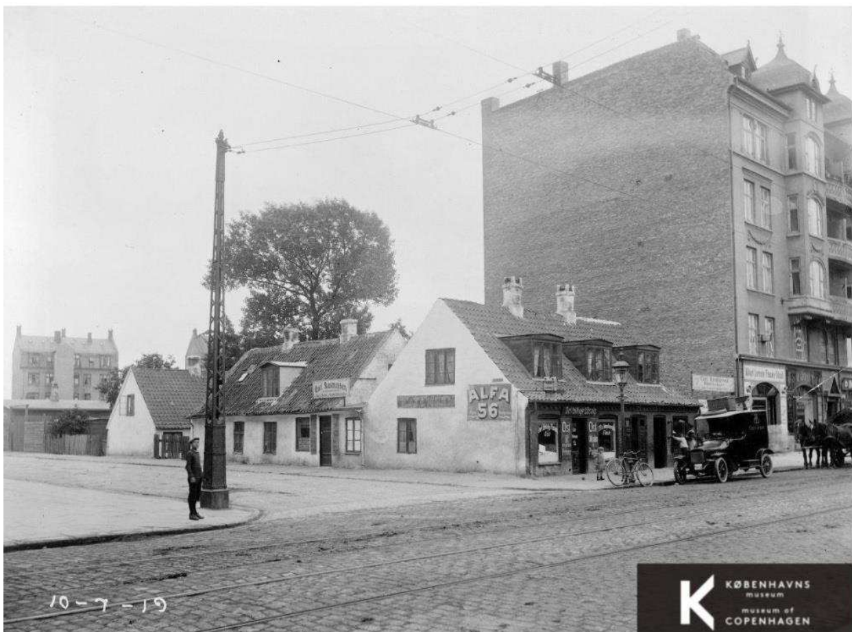
Hjørnet af Hejrevej og Frederikssundsvej 1919. Fotograf ukendt.
