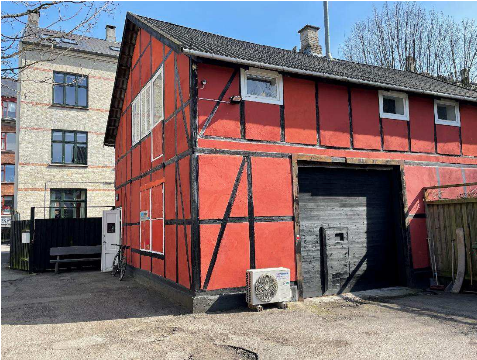
Nordre Fasanvej 269 med bagvedliggende bindingsværksbaghus. Bindingsværksbygningen er opført omkring 1890, mens det grundmurede forhus er fra 1899.
